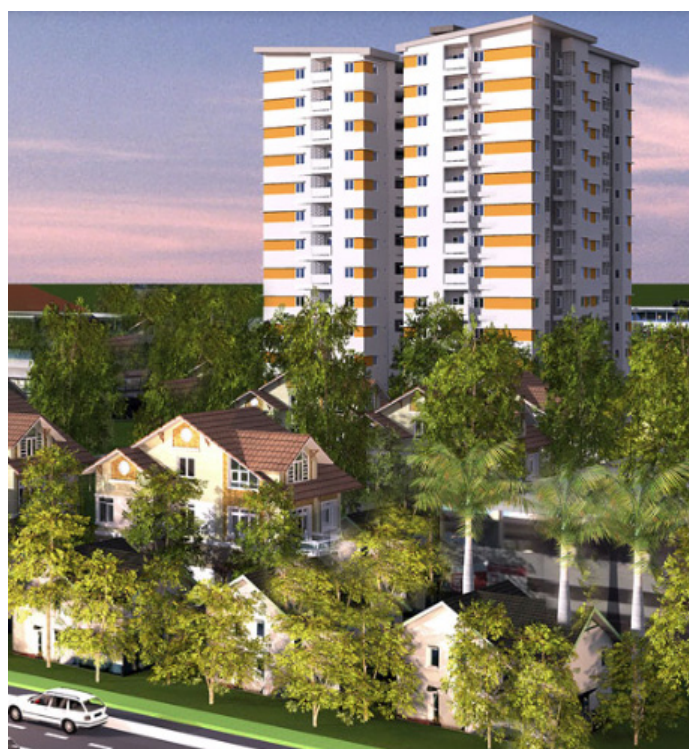
Chung cư S-Home TDH - Phước Long
