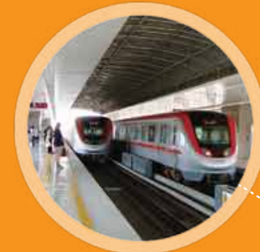
Tuyến Metro Bến Thành - Suối Tiên
